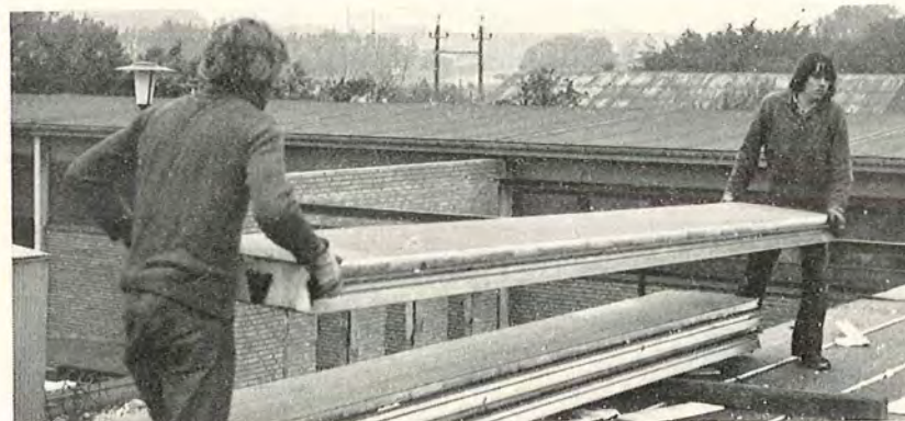
Færdige selv bærende elementer udlægges
